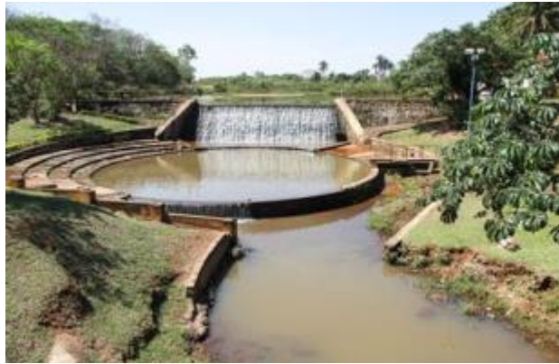
Figura 5 - Represa de Captação de Água no Ribeirão das Cruzes, Araraquara-SP.
