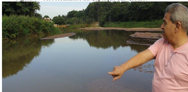
Figura 9 - Assoreamento na Captação das Cruzes.
